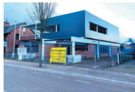
Nieuwe bovenverdieping in aanbouw (afb. boven) & 'Artist Impression' voor-gevel (afb. links)
