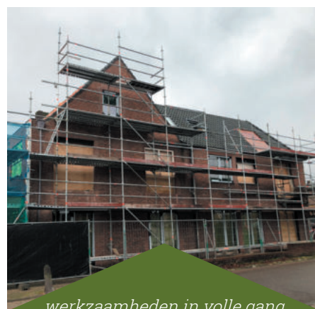
werkzaamheden in volle gang
